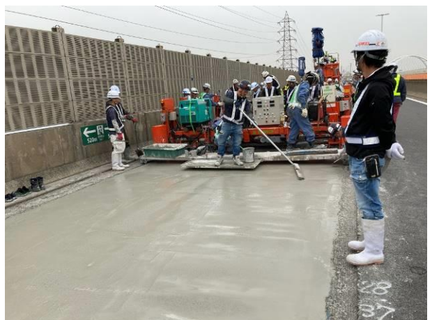
SFRC 舗装の施工状況
