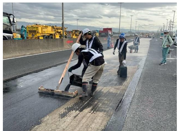
高性能床版防水の施工状況
