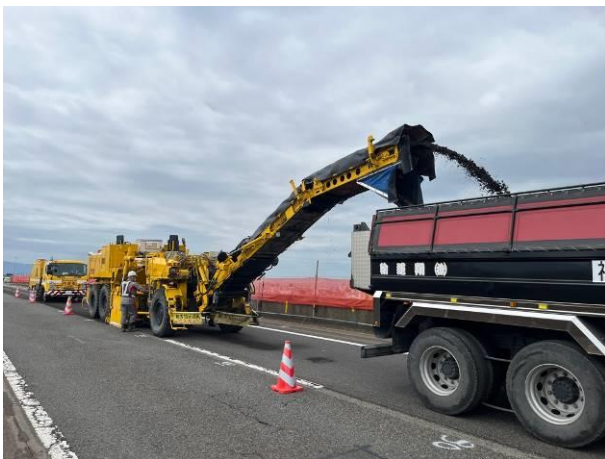
アスファルト舗装の撤去状況
