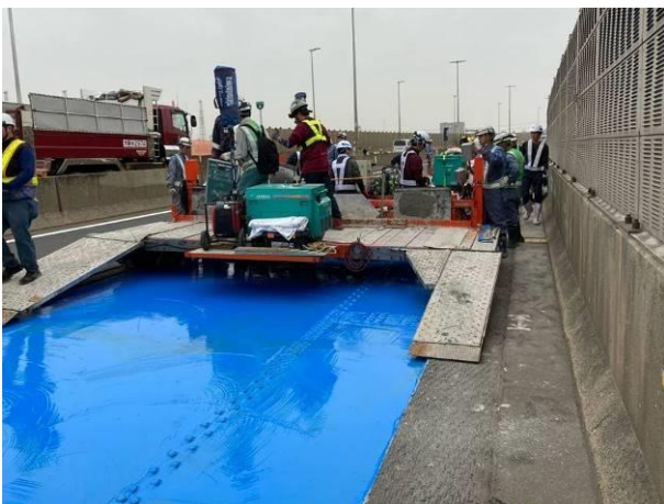
SFRC 舗装の施工状況
