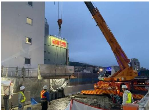
①舗装を撤去し、続いて高欄・中央分離帯もクレーンにより撤去しました。
