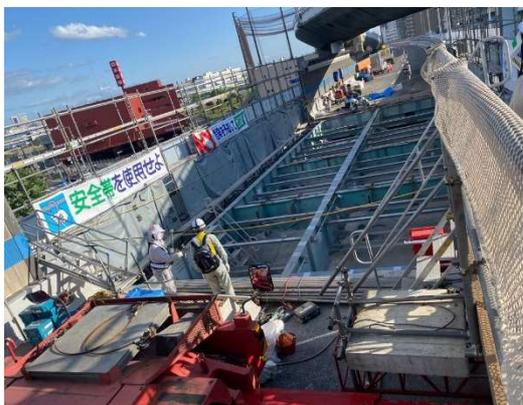
③既設コンクリート床版の撤去が完了し、鋼桁が完全に見える状態になりました。
