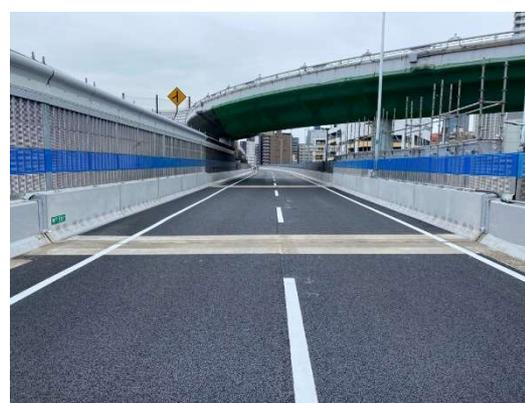
⑥舗装、伸縮継手(ジョイント)、遮音壁の設置・復旧が完了しました。
