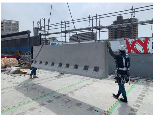
⑤床版と鋼桁を一体化した後に、高欄・中央分離帯を設置しました。
