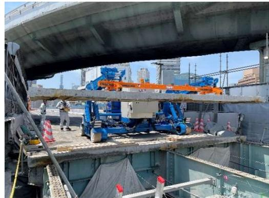
②専用機械を用いて、分割切断した既設コンクリート床版を撤去しました。
