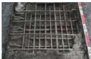
コンクリート床版の陥没（12号守口線）
