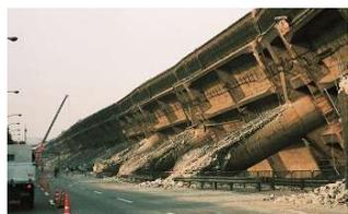
阪神淡路大震災により倒壊した橋脚（3号神戸線）
