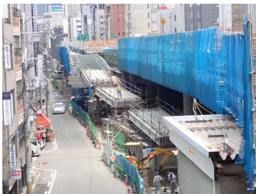
車線規制による上部工の施工状況 (西船場JCT)
