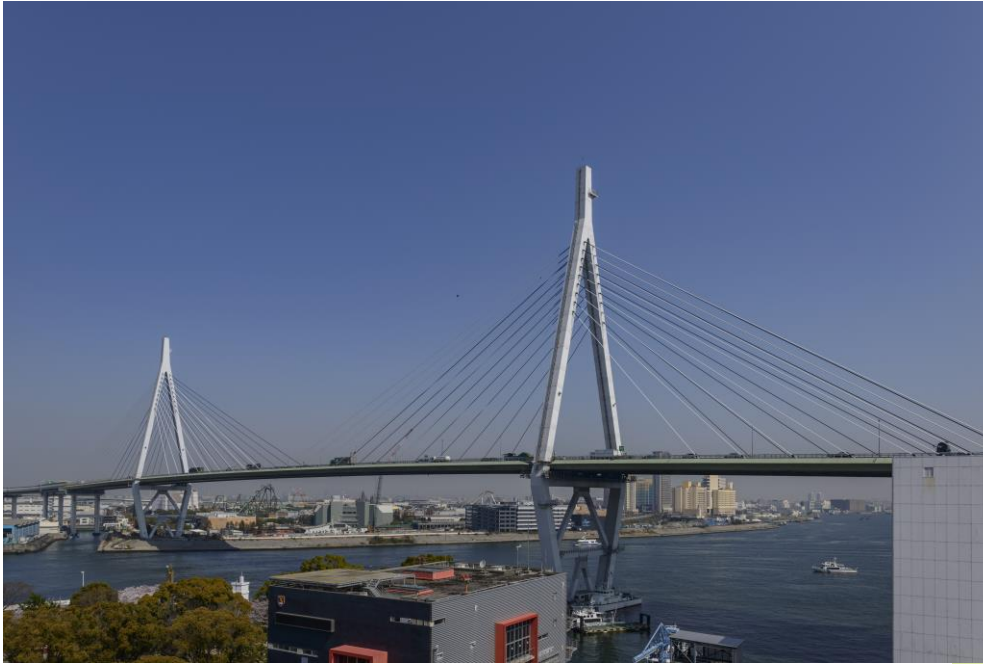
5号湾岸線 天保山大橋
