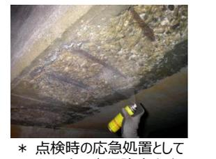
\* 点検時の応急処置としてコンクリートの表面強度向上、鉄筋防錆を目的に表面防護用をスプレーを塗布
