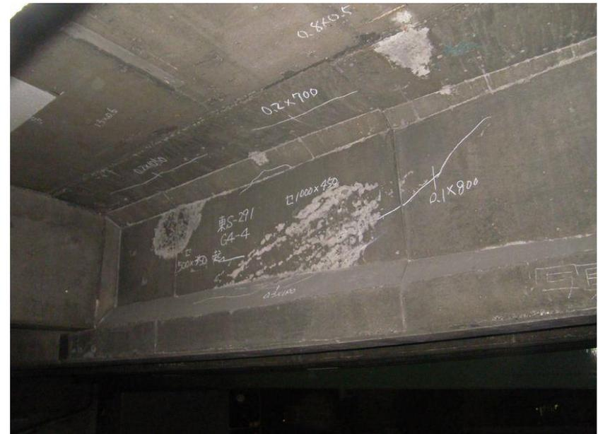
□ PCポステン桁 T桁の分類(2) (損傷位置を基に分類)
