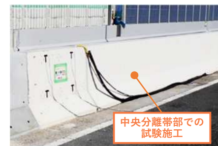
低炭素コンクリートの試験施工状況
