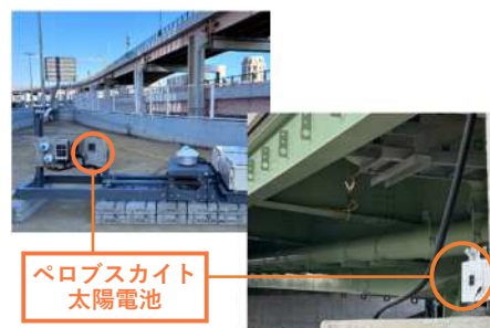
ペロブスカイト太陽電池の性能確認状況
