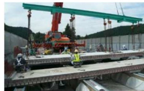
プレキャスト床版の施工イメージ
