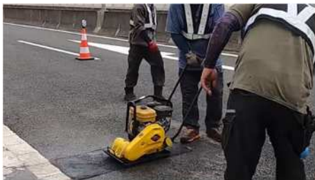
過酷な路面環境で傷んだ舗装の都度補修
