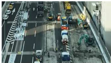
通行止リニューアル工事による全面的な舗装の取り換え(事例:2021年環状線北行RN工事)
