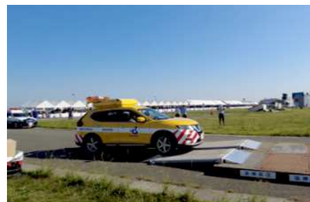
軽量な段差補修資材の開発
