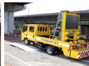
段差発生箇所 仮通路設置訓練
