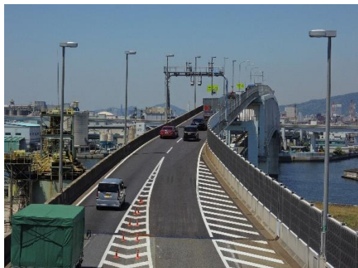
5号湾岸線下り住吉浜出口を2車線化
