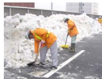
路肩を人力除雪
