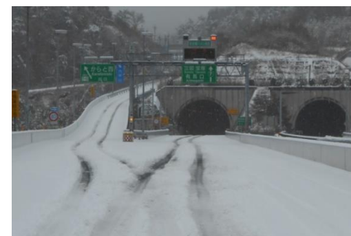
積雪による通行止の状況（北神戸線）
