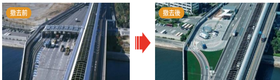
本線料金所撤去跡地をPA整備
