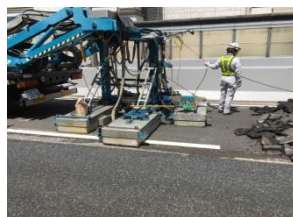
（IHヒーターを使用した舗装撤去工法）
