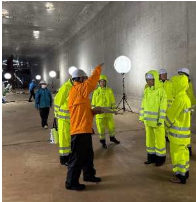
〔大阪湾岸道路西伸部工事現場 視察状況〕
