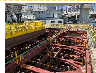
換気所掘削工の実施状況
