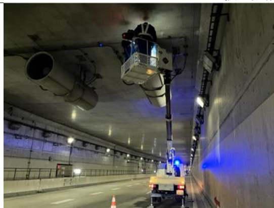
トンネル換気設備定期点検
