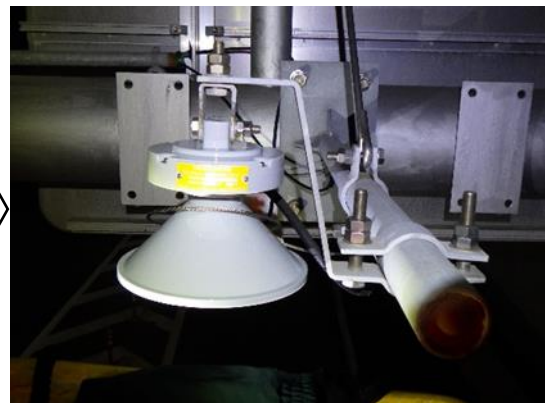
車両検知ヘッド補修後
