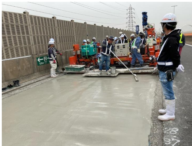
SFRC 舗装施工状況
