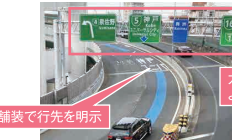
路面表示とカラー舗装で先行を明示
