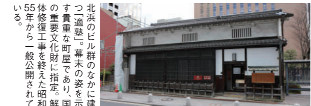
北浜のビル群のなかに建つ適塾。幕末の姿を示す貴重な町屋であり、国の重要文化財に指定。解体修復工事を終えた昭和55年から一般公開されている。
