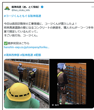
駒栄地区の工事現場に潜入したコージくん(5月)
