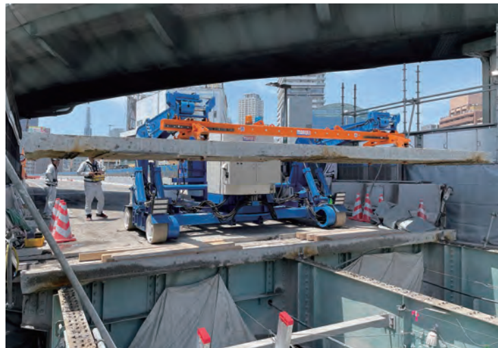
コンクリート床版の取替
