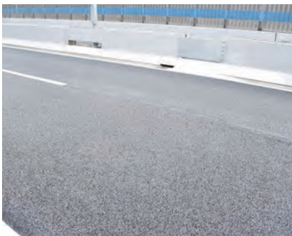
ジョイントレス化(伸縮継手の削減)
