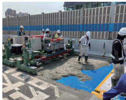
SFRC舗装への打換
