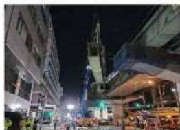
工事中の阿波座付近
