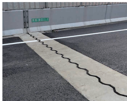
伸縮継手の取替え
