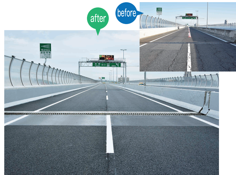
安全性・走行性の向上のための舗装打ち換え
