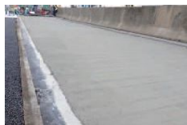
橋梁の耐久性を上げる SFRC舗装に置き換え
