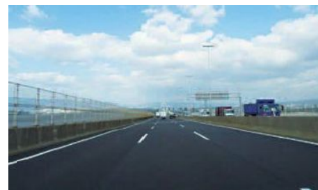
安全性・走行性向上のための 舗装打ち替え
