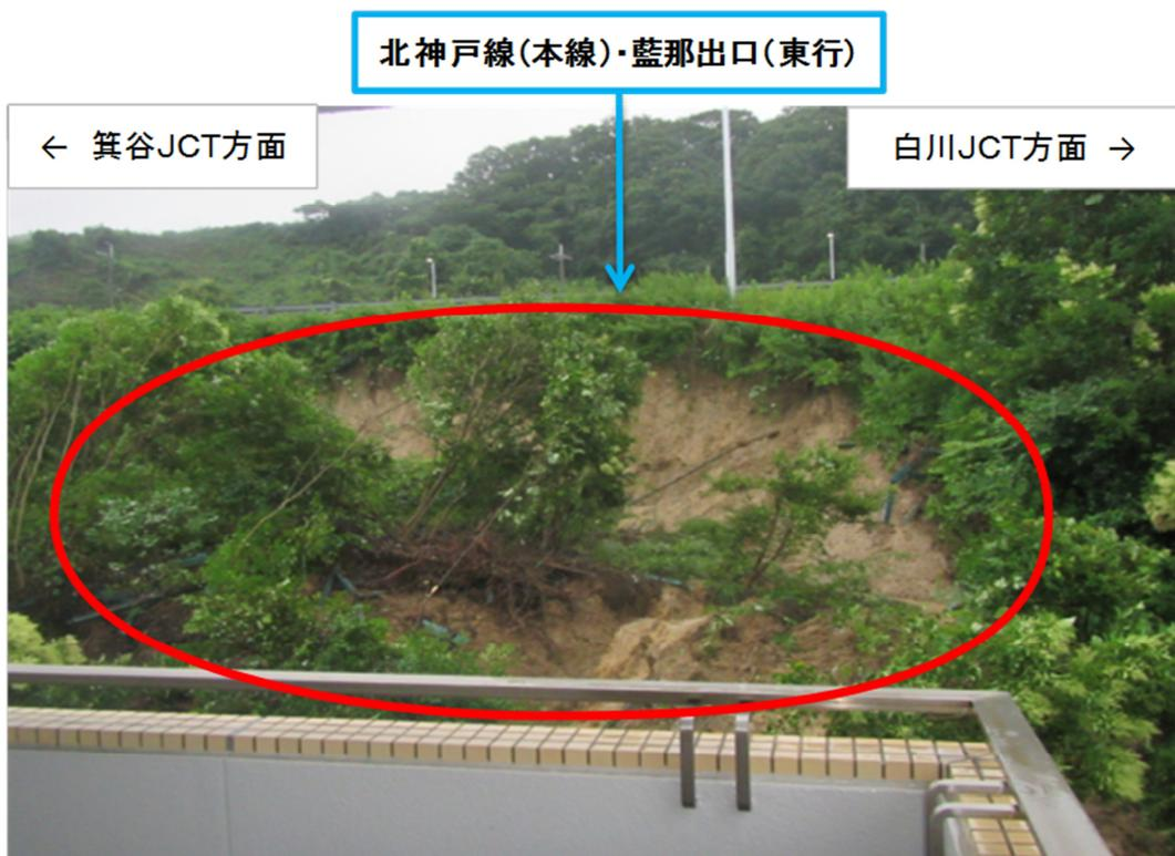
発生箇所 : 藍那出口の土工部分ののり面が崩落
