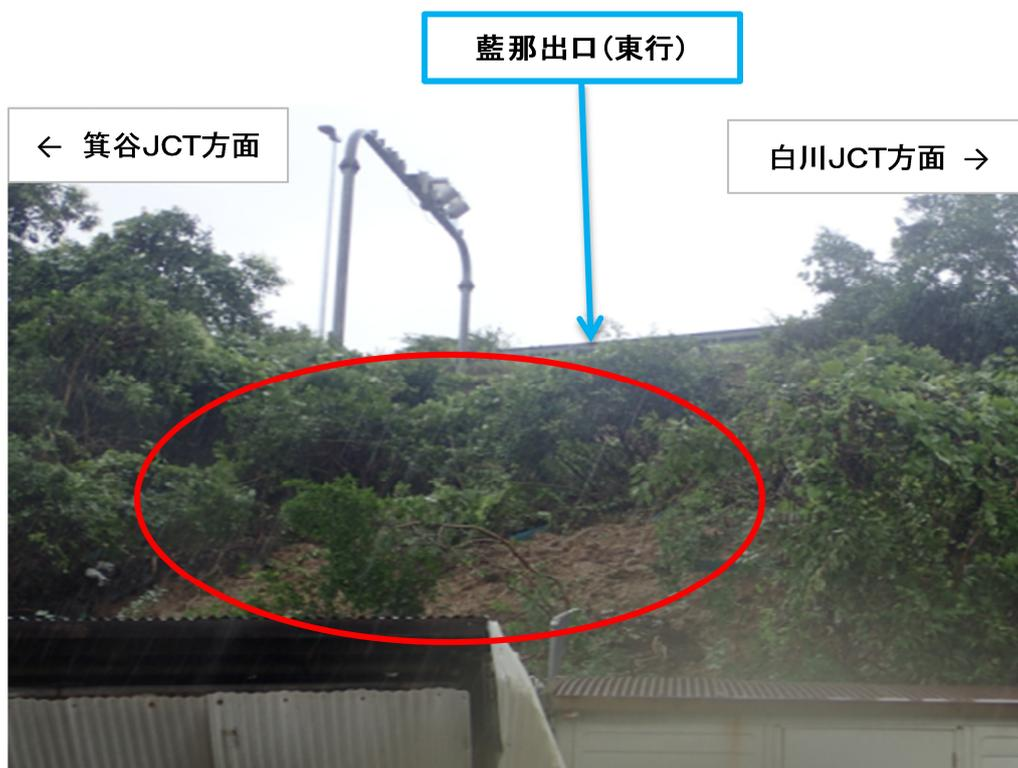
発生箇所 : 発生箇所 に隣接して、同様にのり面が崩落
