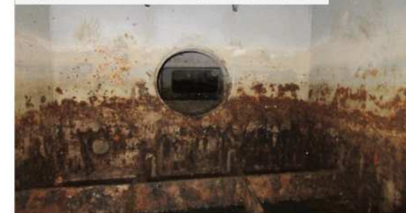
鋼製フーチング内部の腐食状況
