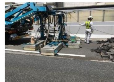
IHヒーターを使用した舗装撤去工法
