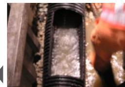
アスファルト系材料を用いることでセメント成分の排水管への流れ込み(排水機能の低下リスク)を防止
