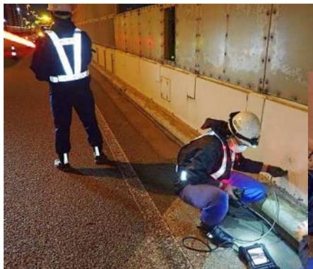
点検孔が小さいためファイバースコープ等を用いて点検
