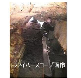
沓座コンクリートの破損・桁端部の発錆
