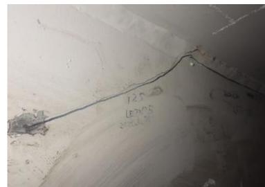
新たに発見された鋼床版疲労き裂
