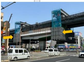
仮設桁を用いた既設桁の撤去工法
