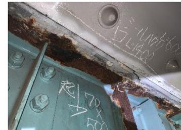
補強鋼板の腐食 (3号神戸線)
