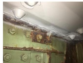
補強鋼板からの漏水、鋼桁の発錆 (12号守口線)
