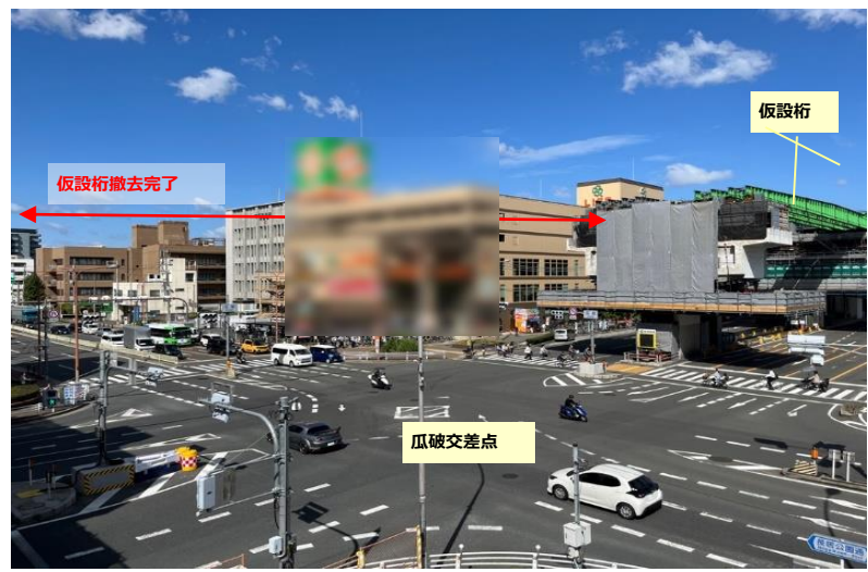
仮設桁の撤去状況
