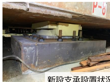
新設支承設置状況
