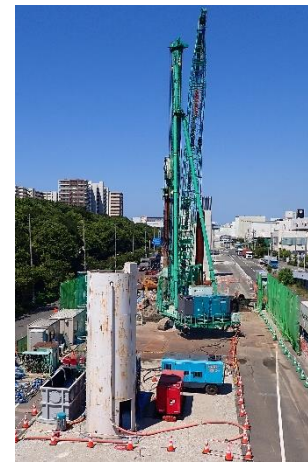
鋼管杭工の実施状況
