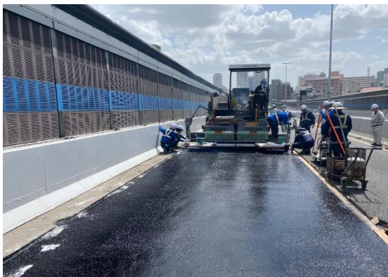
舗装工事（神戸線リニューアル工事）
