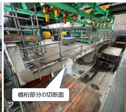
橋中央部分の切断状況
