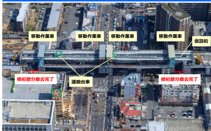
仮設桁、移動作業車、運搬台車設置状況(3月5日 空撮)
