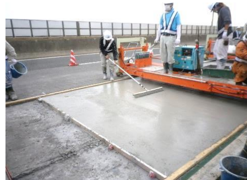
SFRC舗装の施工状況
