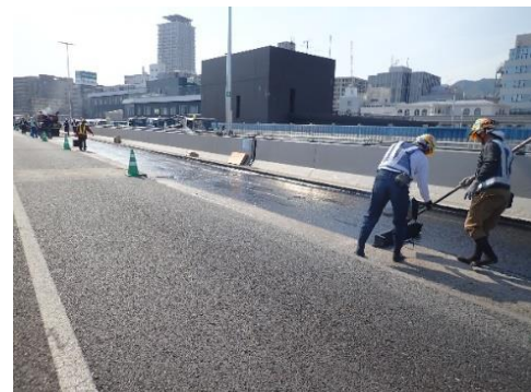
高性能床版防水の施工状況
