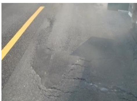
舗装の損傷
