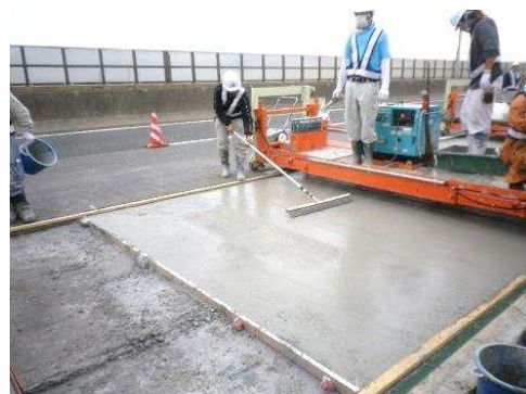
SFRC舗装の施工状況
