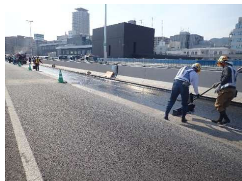
高性能床版防水の施工状況
