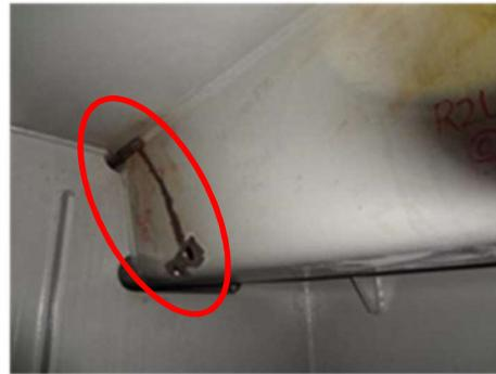
4号湾岸線の鋼床版き裂損傷状況
