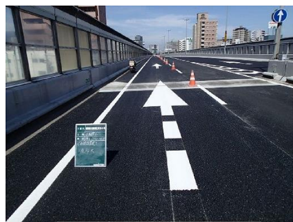
舗装工事施工完了後の様子
