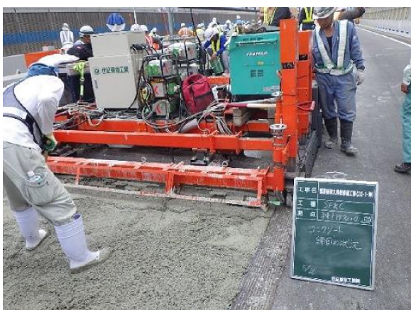
長寿命化対策（SFRC舗装）施工の様子
