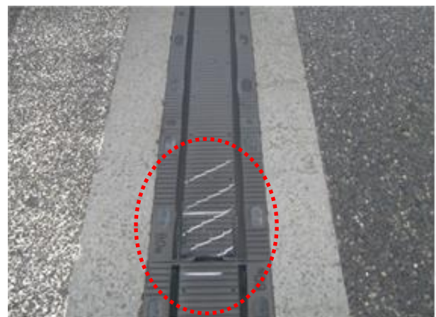
3号神戸線における舗装・伸縮継手損傷の状況
