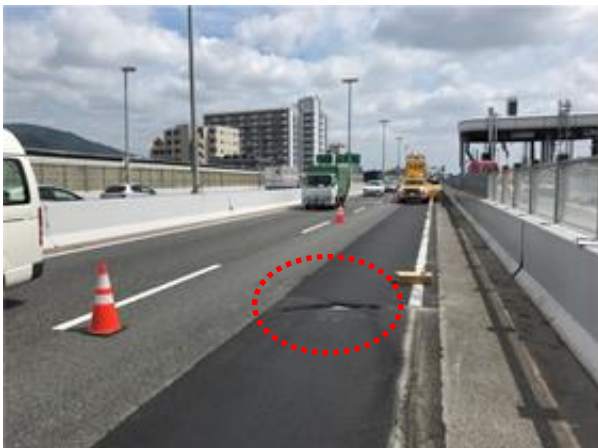
3号神戸線における舗装・伸縮継手損傷の状況
