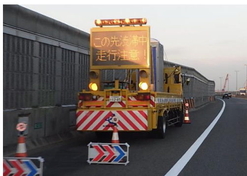
仮設LED表示板(標識車)
