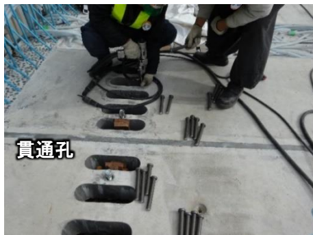
ずれ止めスタッドの設置 (玉出入口)
