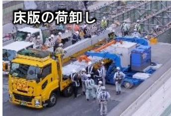
床版の荷卸し トラックで運搬してきた UFC 道路橋床版を専用架設機で把持
