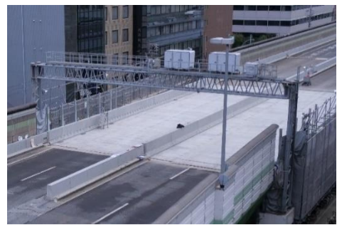
UFC 道路橋床版を用いてリニューアルした阪神高速 12 号守口線本線
