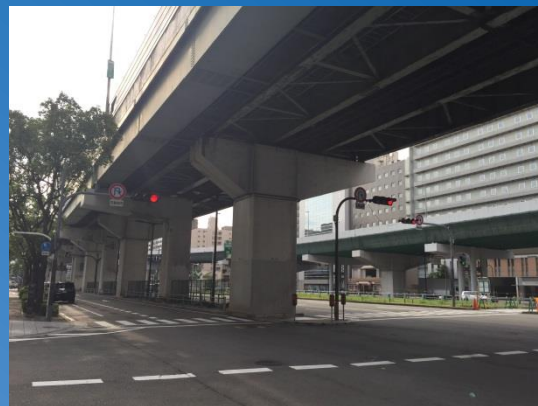
中央大通り 東上P42付近の状況 （2020年8月撮影）
