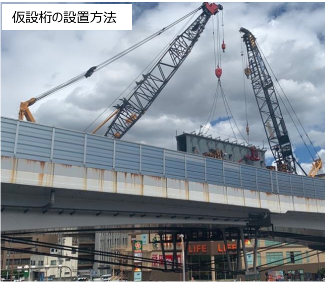
隣接桁上での組立て・送り出しを直接、撤去桁上での組立てに変更
