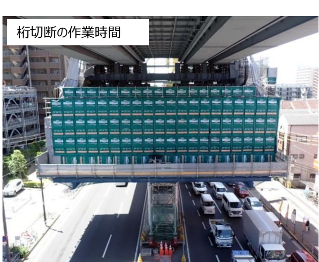
昼間作業と想定していたPC箱桁の切断を高度な防音対策の実施により、地域の皆様の理解を得て夜間にも実施
