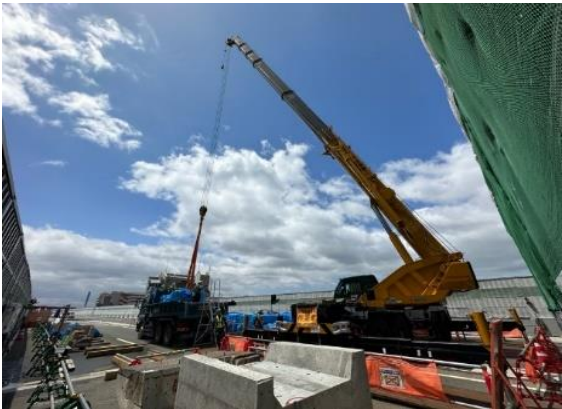
ブロックのダンプ積み込み
