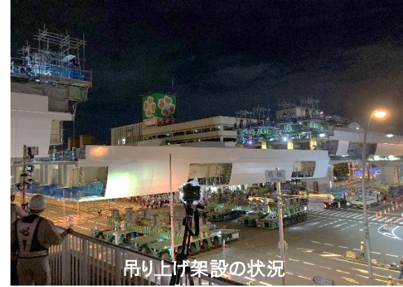
大阪市所有地を活用した鋼桁の地組
