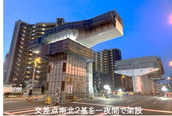
鋼製梁のクレーン架設状況
