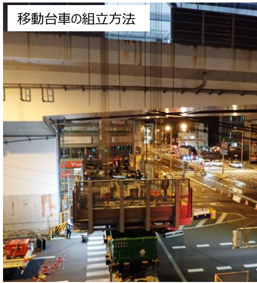
施工ヤードや多軸台車の活用により作業時間の短縮と規制回数を削減
