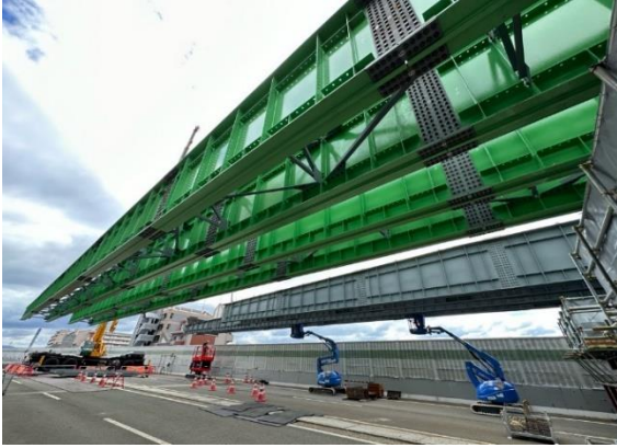
手延べ桁の設置
