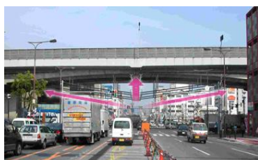
ケーブルによる補強状況
