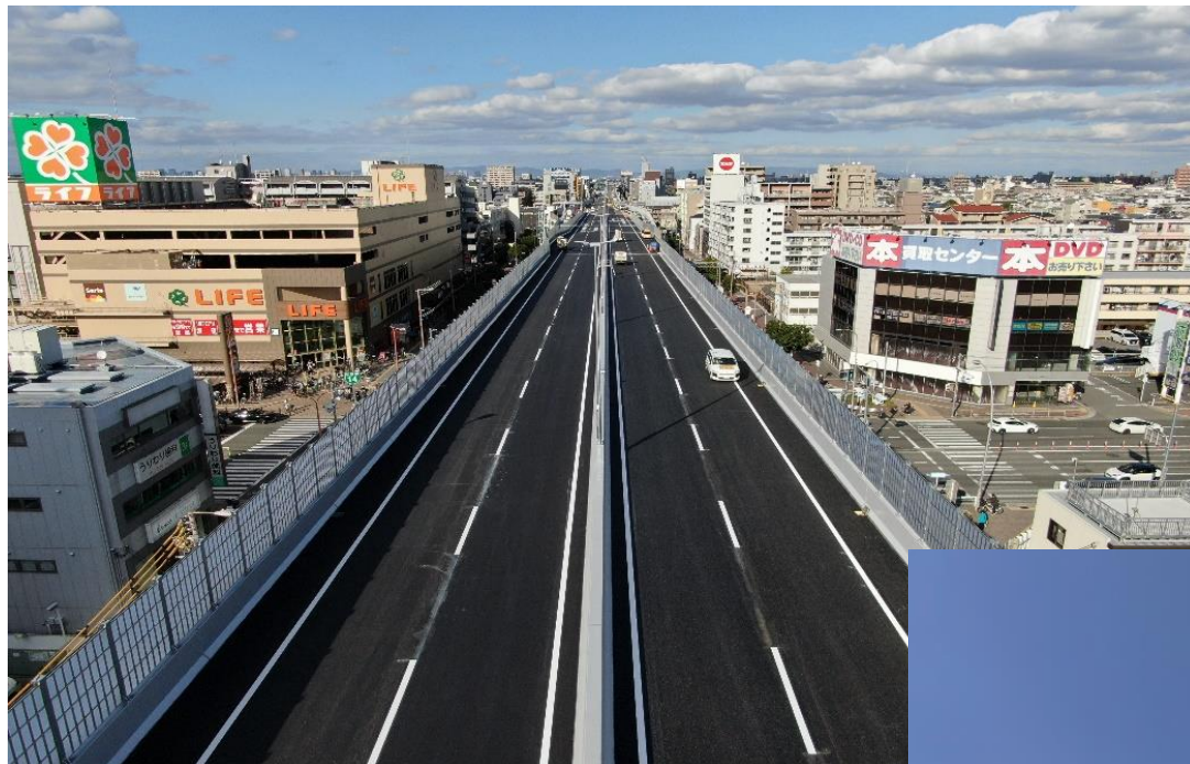
完成全景（高速道路本線部）
