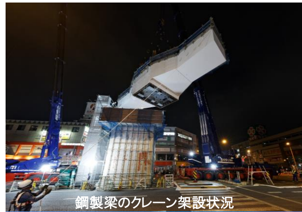
鋼製梁の架設
