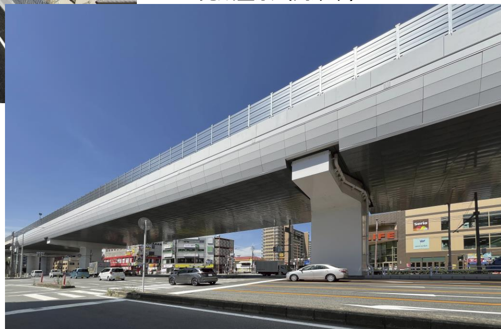
完成全景（高架下）
