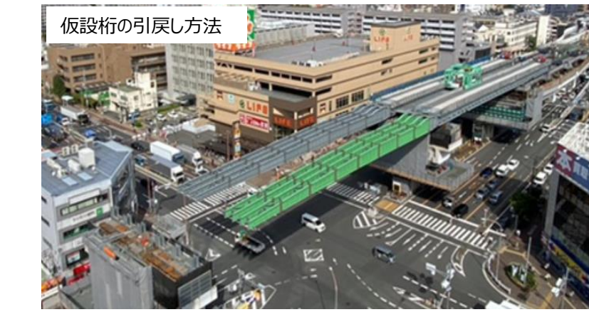
上下線別々での引戻しから上下線一括での引戻しに変更
