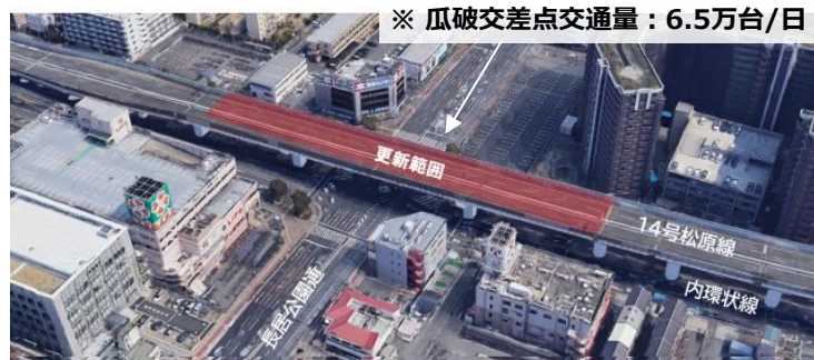
更新範囲と現場周辺の状況
