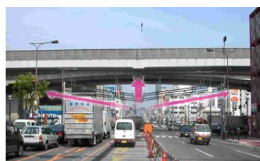
ケーブルによる補強状況
