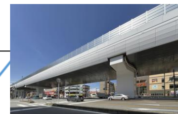
完成全景（高架下）
