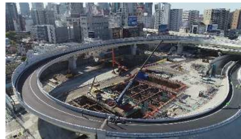
ランプ部舗装工事の完成状況
