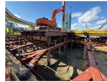
換気所掘削工の実施状況
