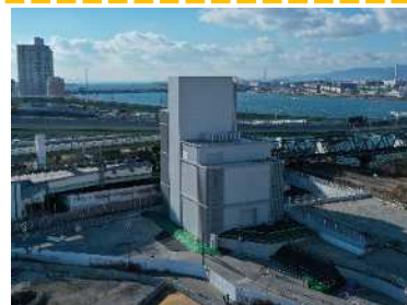
換気所建物の完成状況
