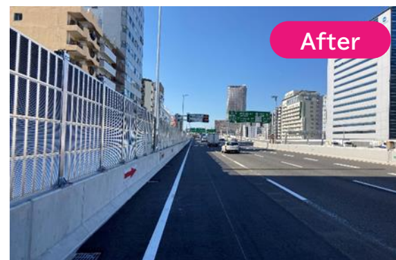
▲路面の一体化により縦目地を解消しました
