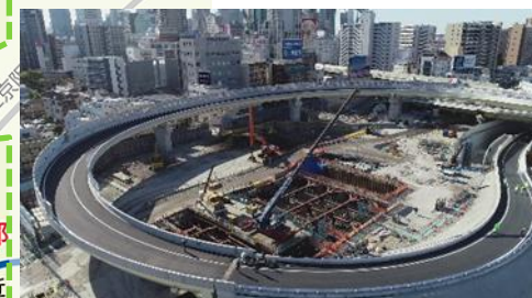
ランプ部舗装工事の完成状況
