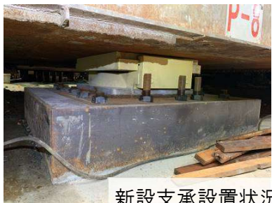
新設支承設置状況
