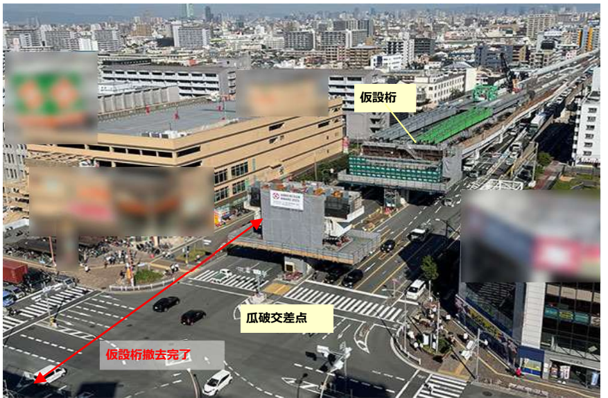
仮設桁の撤去状況
