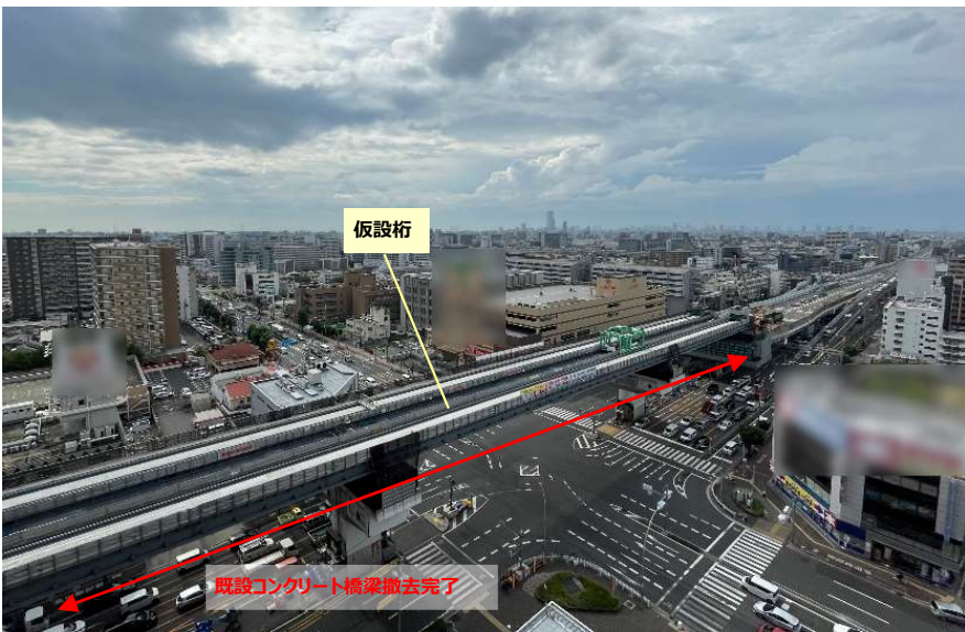
既設コンクリート橋梁の橋桁部分の撤去完了
