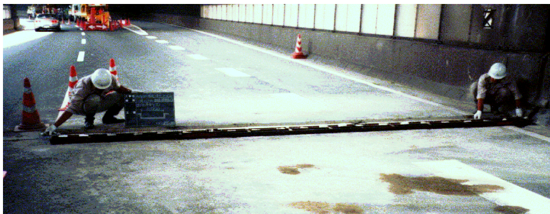
伸縮継手補修実長の全景の例
