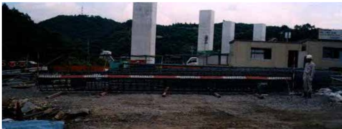
鉄筋かごの実長の全景の例
