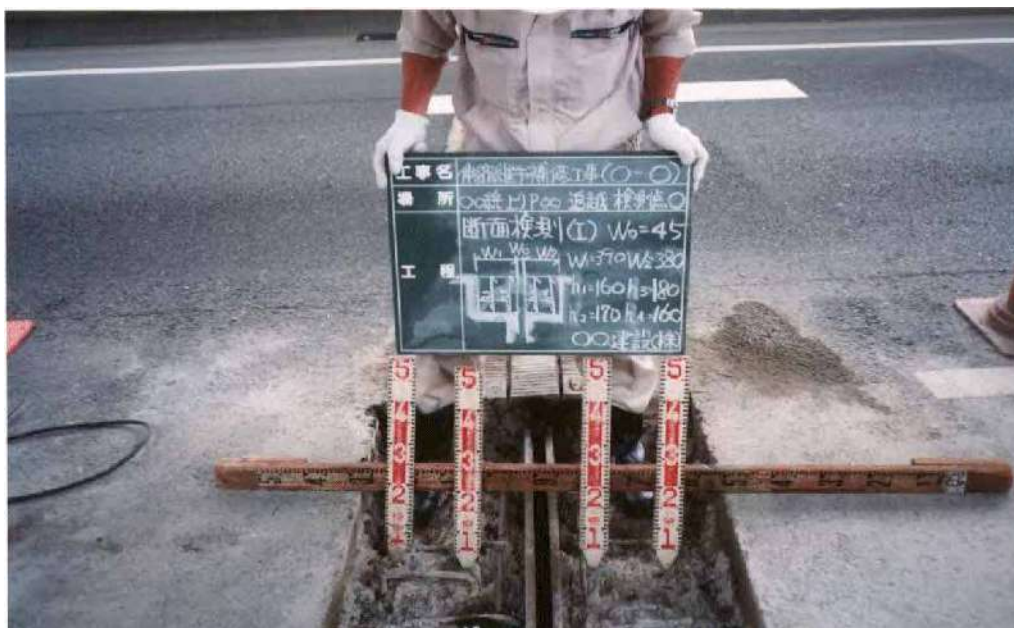
伸縮継手切削断面の計測
