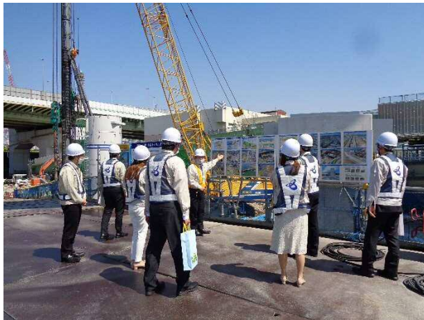
〔淀川左岸線(2期)工事現場 視察状況〕
