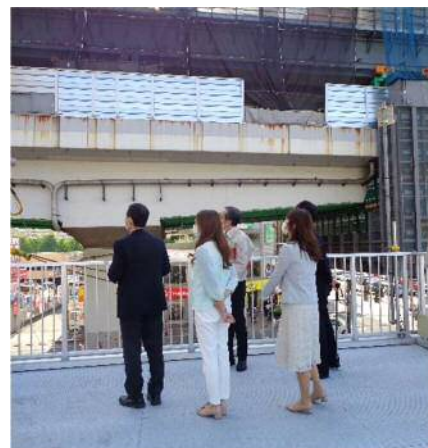
〔喜連瓜破工事現場 視察状況〕
