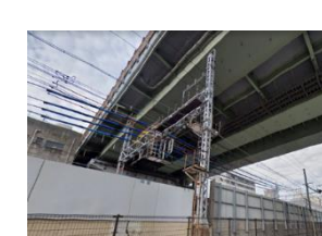
軌道上への点検用足場設備の設置
