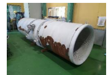
【例】損傷したトンネル換気設備の更新
