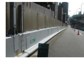
遮音壁・透光板の取替
