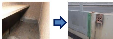
内面の腐食に対して、鋼板補強・部分取替を実施。
