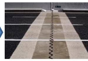
伸縮継手の取替
