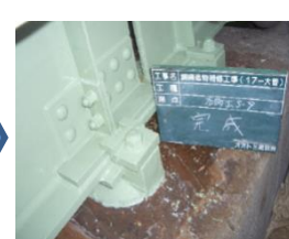
鋼板補修・ボルト取替
