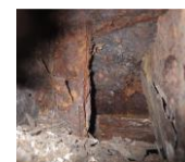
内面の腐食
