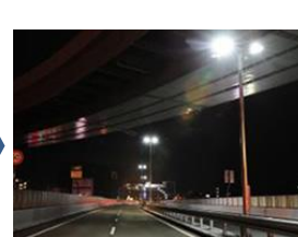
照明柱(標識柱)の取替
