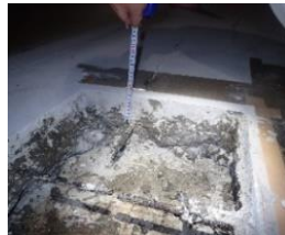
舗装面のはつり調査 (PC鋼材の目視確認)
