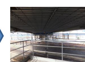
軌道上への点検用足場設備の設置
