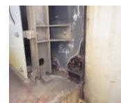
外面の腐食
