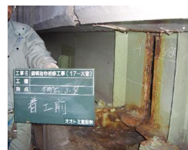
鋼板補修・ボルト取替
