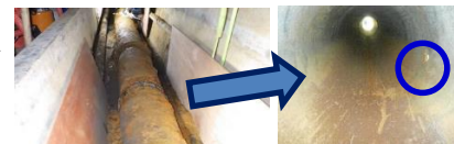
【例】劣化した消火本管の取替
