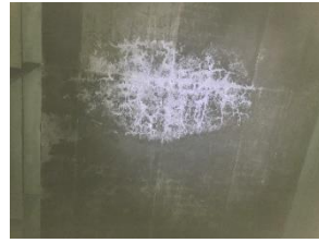
下面のひび割れ・遊離石灰 (4号湾岸線 2019年12月撮影)
