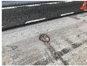
床版面の不陸・露出鉄筋 (1号環状線 2020年11月撮影)
