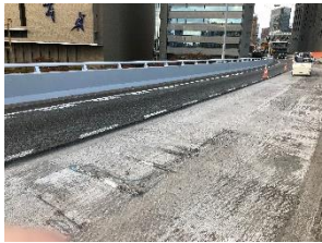
床版面の不陸・露出鉄筋 (1号環状線 2020年11月撮影)
