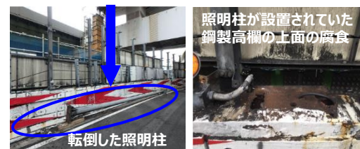
外面の腐食
