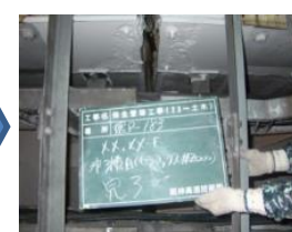
塗装塗替（さび・腐食対策）
