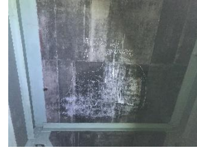
下面のひび割れ・遊離石灰 (4号湾岸線 2019年12月撮影)
