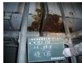
塗装塗替（さび・腐食対策）
