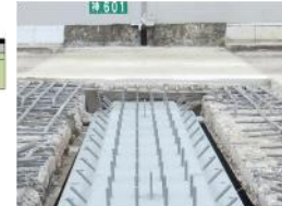
橋の継ぎ目による段差の解消 (漏水による腐食対策、重防食塗装も実施)
