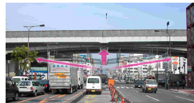
応急対策 (ケーブルで左右から引き上げ)
