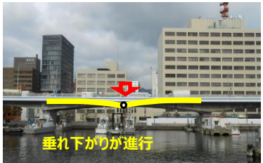
路面（ヒンジ部）の沈下
