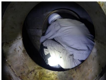
狭隘で点検困難な鋼製フーチング内の空間
