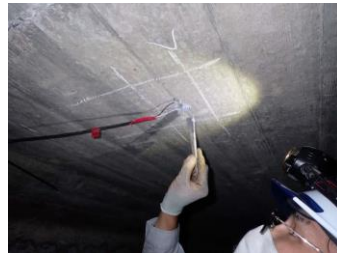
コンクリート水分量の計測 （箱桁内、2021年9月撮影）
