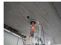
コア削孔調査（2021年10月撮影）
