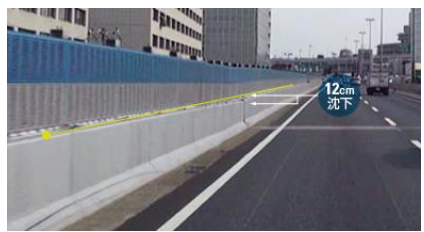
路面（ヒンジ部）の沈下
