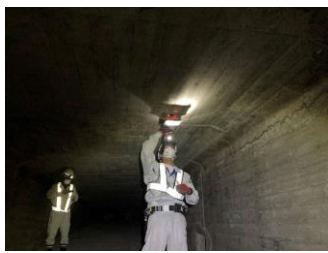
RCLレーダ探査 （箱桁内、2021年9月撮影）
