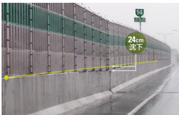
路面（ヒンジ部）の沈下
