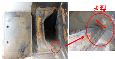
溶接部を起点とした主桁（下フランジ）の疲労き裂
