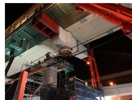
橋脚梁部の施工 (2022年8月撮影)
