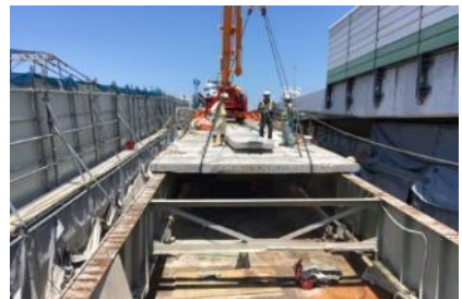
15号堺線 玉出ランプ 既設床版の撤去
