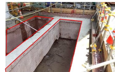
既存基礎の上面のコンクリートの撤去 (2022年9月撮影)
