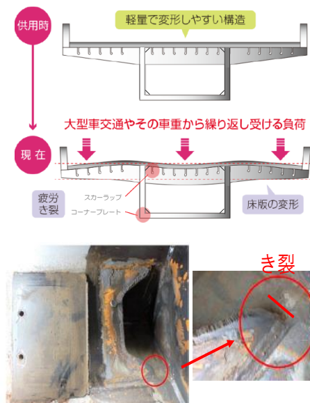
溶接部を起点とした主桁（下フランジ）の疲労き裂
