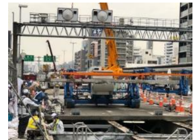
11号守口線 床版の設置
