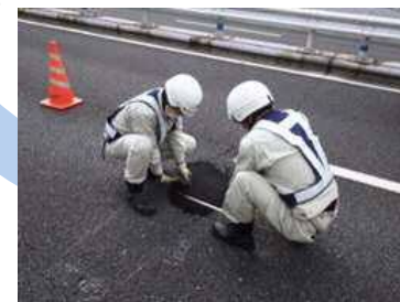
損傷(穴ぼこ)補修
