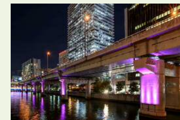
橋脚のライトアップ
