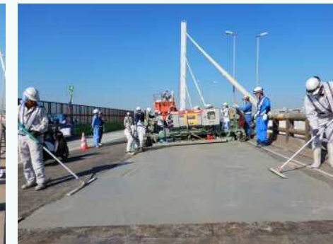
【SFRC舗装打設】
