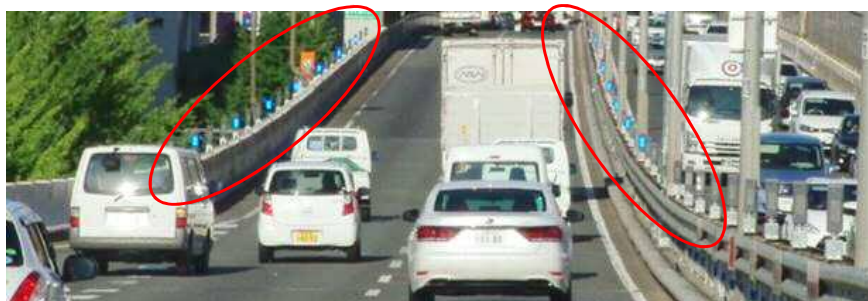
青色ライトの点滅が前方に流れることで適正な走行速度を促す速度回復誘導灯(13号東大阪線森之宮付近の上り坂)
