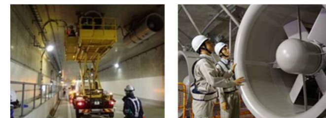
【現状】 高所作業車による近接点検を実施（通行規制有り）
