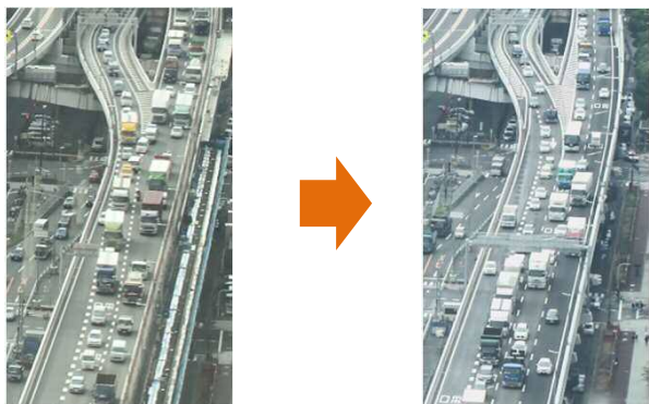
車線を増設し、走行しやすい区画線に改善(16号大阪港線・3号神戸線合流部)
