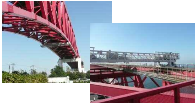
橋梁点検車の活用
