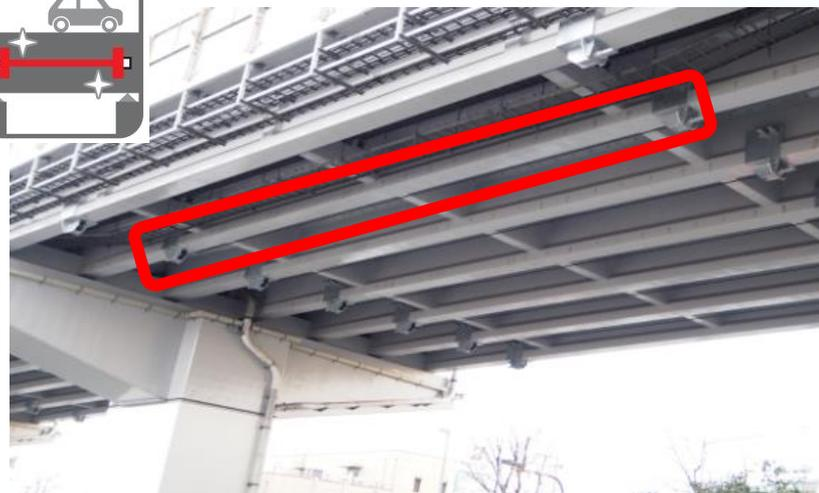
PC桁外ケーブル補強状況
