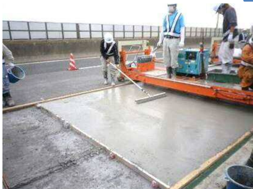
SFRC舗装により鋼床版の耐久性を向上
