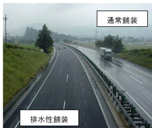
排水性舗装の施工例
