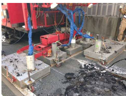
IHヒーターによる加熱状況
