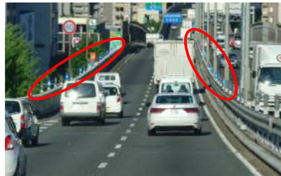
速度回復誘導灯（高欄上部）
