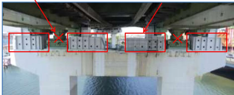
上部工（橋桁）の耐震対策
