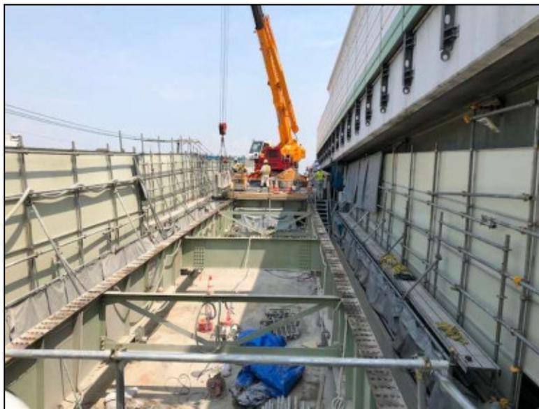
〔損傷したRC床版の撤去〕
