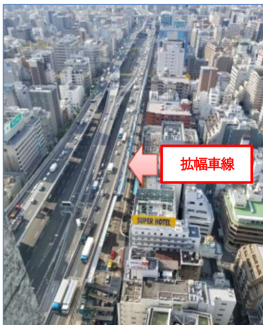
《大阪港線拡幅部》 （高架部の右端が拡幅車線）
