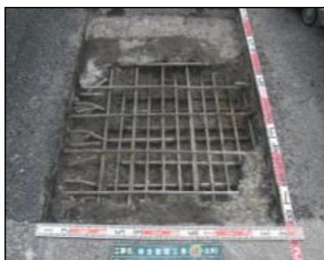
RC床版損傷例（陥没）
