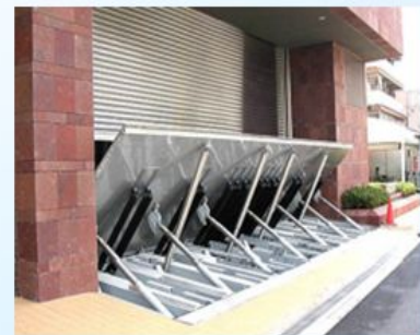
防潮板の設置
