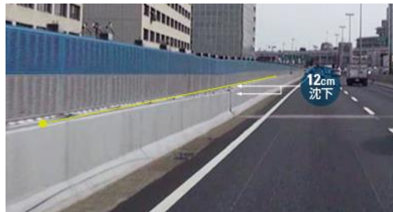
橋桁の中央付近が設計時の想定よりも大きく沈下
