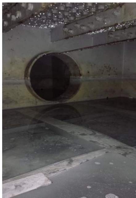
湊町鋼製 フーチング 内部状況調査
