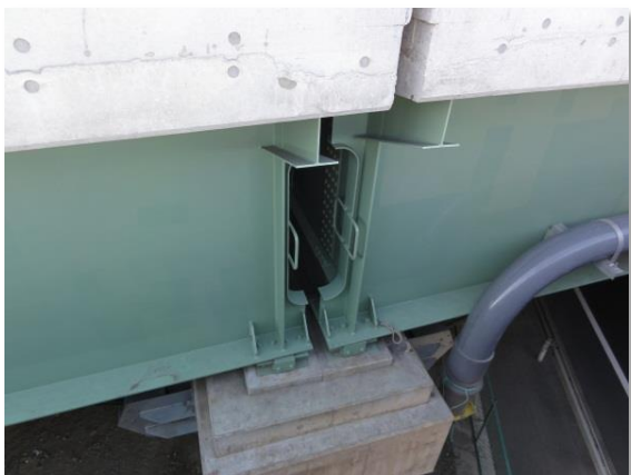
桁端マンホール設置例
