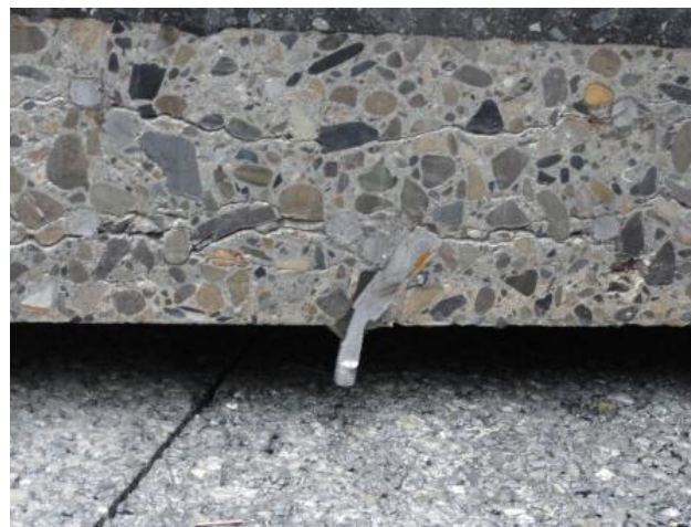
R C床版 切り出し
