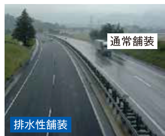
排水性舗装の施工例
