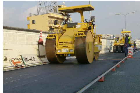
舗装の施工状況
