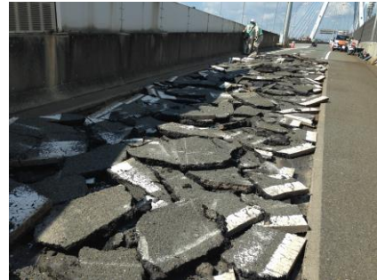
加熱後の掘り起こし状況
