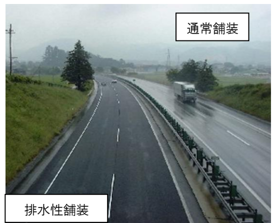
排水性舗装の施工例
