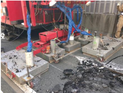
IHヒーターによる加熱状況
