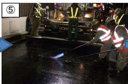
⑤ 鋼床版部基層の舗装施工
