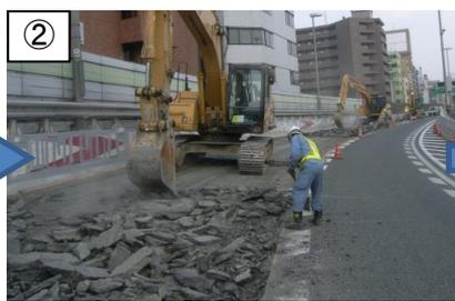
② 鋼床版部の舗装を機械で剥ぎ取り
