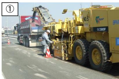
① 大型切削機により舗装を剥ぎ取り
