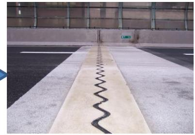
橋の継ぎ目の補修により段差の解消
